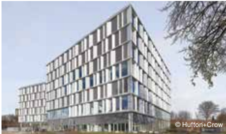
丹麦微软大楼 Microsoft Denmark
